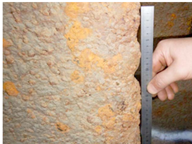
Рис. 2. Нарушение профиля кромки, коррозионный износ поверхности колонны статора
