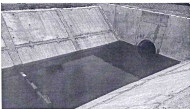
Рис. 2. Нижний бьеф (а) и русло канала (б) одноочкового водовыдела канала УС-4
