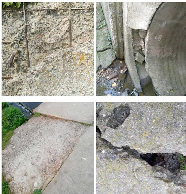
Рис. 1. Дефекты бетонных и железобетонных конструкций ГТС
