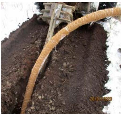
Рис. 1. Укладка дрена в траншею с защитно-фильтрующим материалом из кокосовой койры
