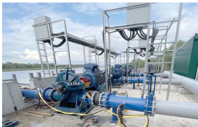
Рис. 1. Монтаж электрифицированного насосного оборудования на верхней площадке насосной станции, 05.08.2022
