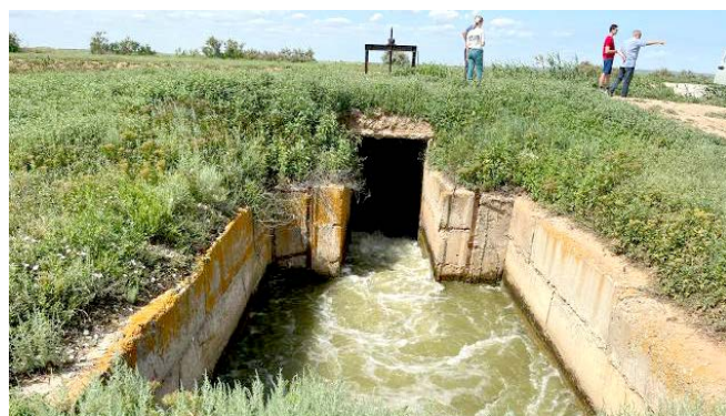
Рис. 1. Входной оголовок (а) и нижний бьеф сооружения (б) водовыдела с переездом в Яшкульский РК
