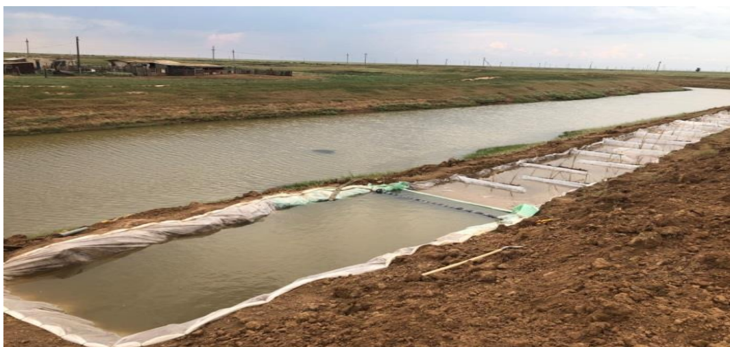
Рисунок 2 – Общий вид опытного биосорбционного сооружения на Сарпинской рисовой оросительной системе в Калмыкии
