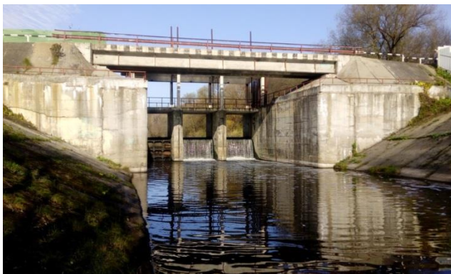
Рис. 4 Трехпролетный водосброс на р. Пахра
