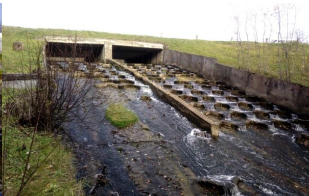
Рис. 5 Быстроток с искусственной шероховатостью водосбросного сооружения
